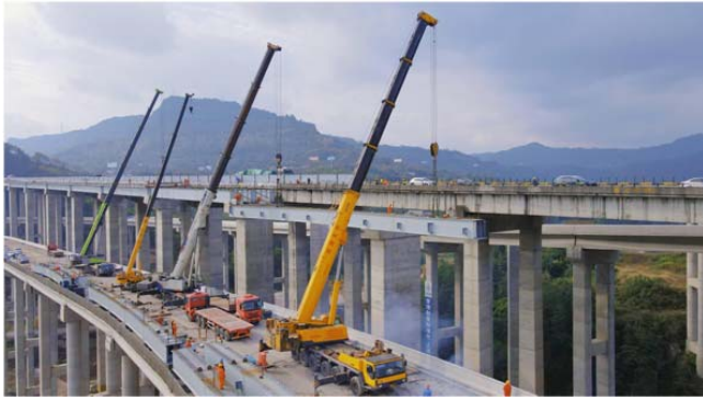
图1 公路桥梁施工
