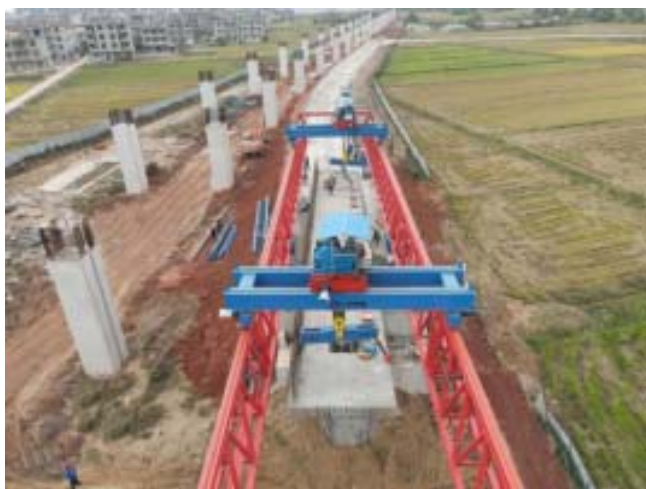
图1 道路桥梁施工现场图
