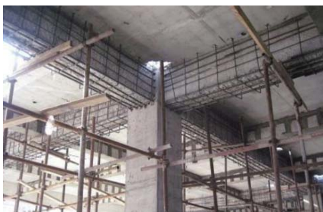
图2 桥底施工现场图
