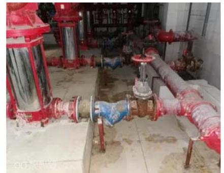
图25(消防水泵吸水端)
