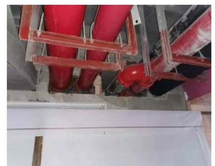
图9(套管,防火封堵)
