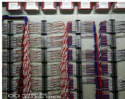
图23(端子箱接线)
