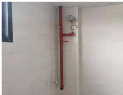
图11(末端放水装置)
