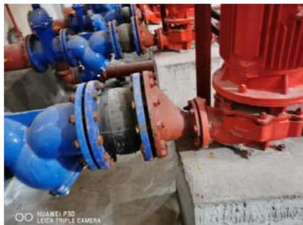
图28(水泵吸水端偏心接头)
