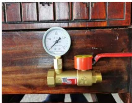
图12(末端试水装置)
