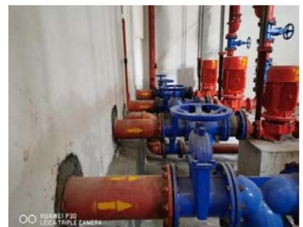
图27(水泵吸水端)
