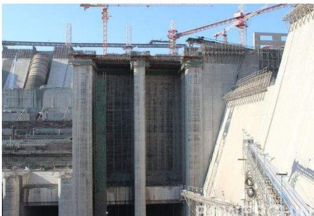
图1 水利水电工程滑模施工技术
