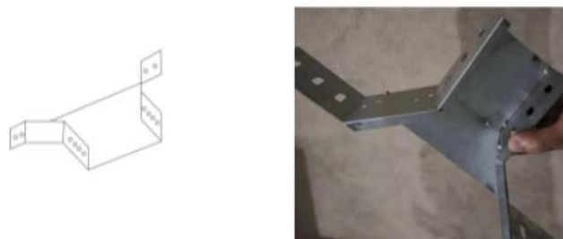
图7 可调节装配式变径接头
