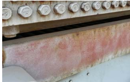
图3空气冷却器四周封堵不严,漏风严重
