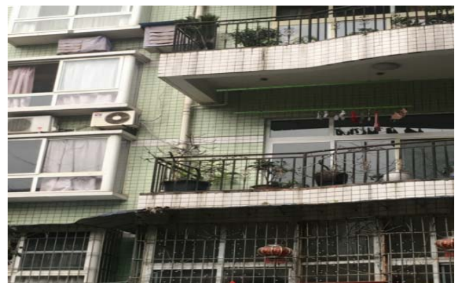
a. 生活污水接入雨水管网
