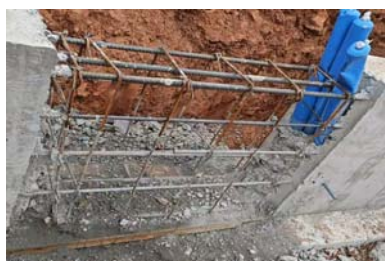
图2 基础梁后浇带留设
