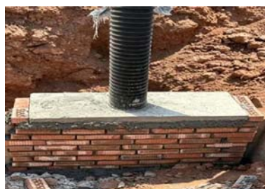
图4 础梁后浇侧墙砌筑
