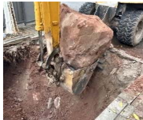
图2 开挖方式清除障碍物
