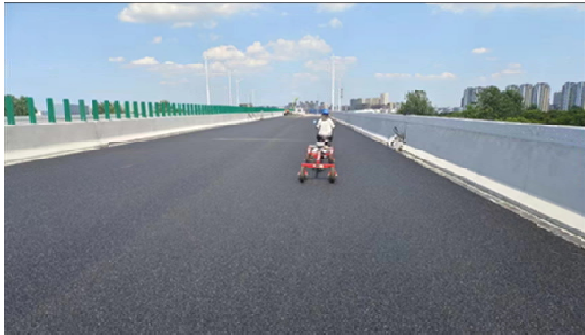
图3 压实完成面平整度检测
