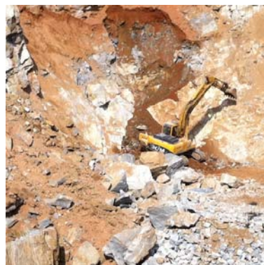
图2 现场施工照片
