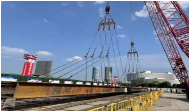
图2 双机抬吊示意及实物图
