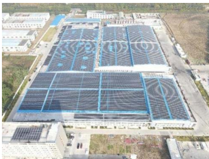
图1 某分布式光伏项目
