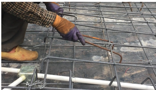
图5 工人提起负筋网架放置马凳筋
